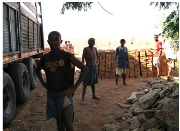
Bild: Die Steine für das Toilettenhaus sind angekommen
